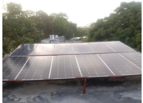
A l'école Marie-Soleil, des panneaux solaires ont été installés en janvier 2026.
